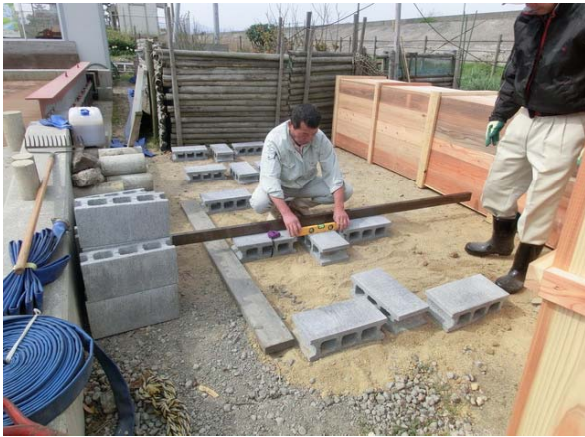
シマミズ箱基礎設置状況
